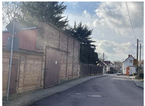
Ansicht aus Richtung Nordosten
