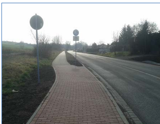
Radweg entlang der L145 (Ortslage Teicha)
