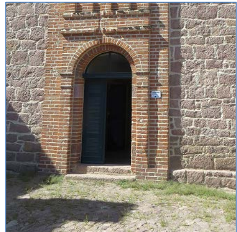
Krosigk, Beispiel Fassadengliederung
