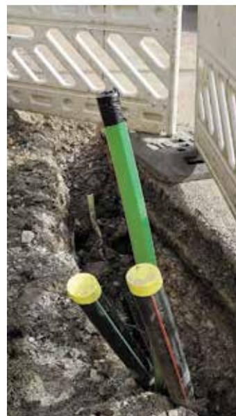
Die dicken Glasfaserkabelhüllen schauen noch aus dem Boden.
